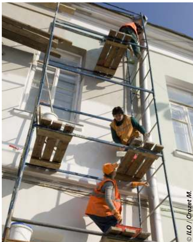
Trabajo de reparaciones en una de las calles centrales de Moscú (sin medidas de seguridad adecuadas).
