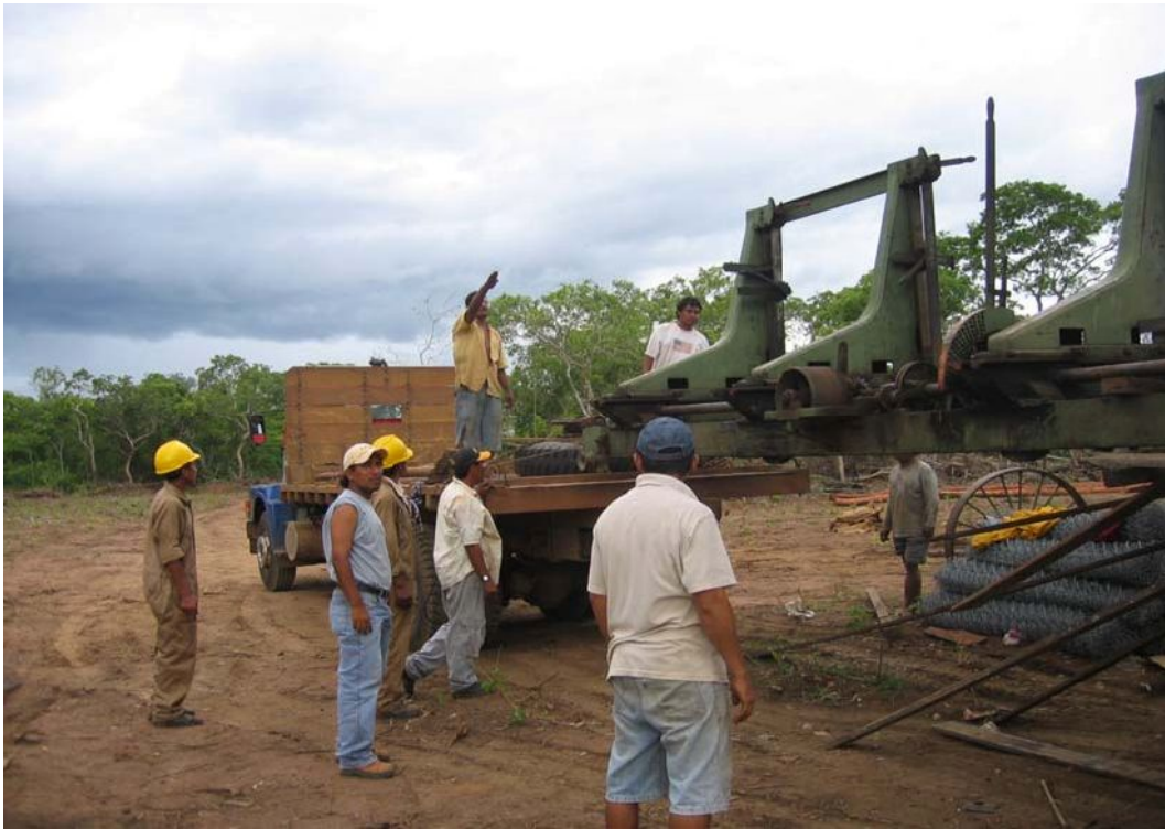
FOTO 7.2. Momento de la instalación de los componentes del aserradero de San Miguel
